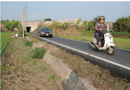
彰化市景宗路的邊坡以成排石塊堆砌而成(左)，圖右為路邊的石枕塊。
