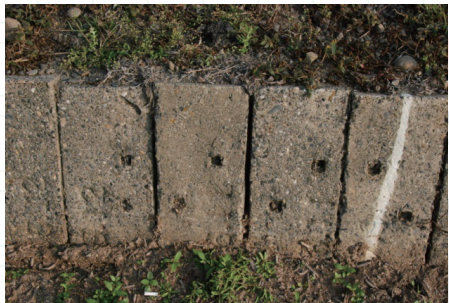
彰化市景宗路的邊坡以成排石塊堆砌而成(左)，圖右為路邊的石枕塊。
